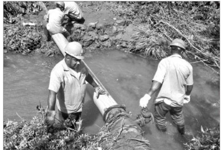
Equipes do SAAE instalaram nova tubulação no sistema de água após os danos com as chuvas
