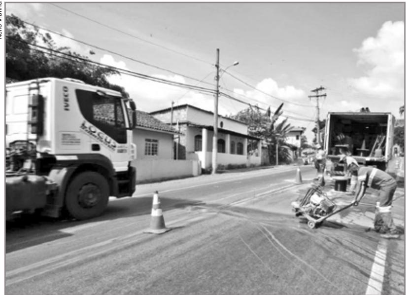
Obras de instalação de radares eletrônicos na Rodovia dos Inconfidentes, em Cachoeira do Campo
