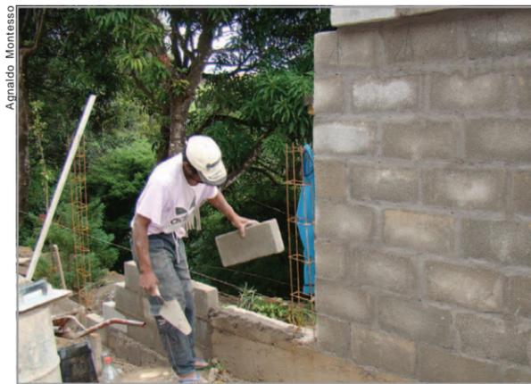
Construção do muro de arrimo trará a diminuição na quantidade de terra que se desprende quando chove
