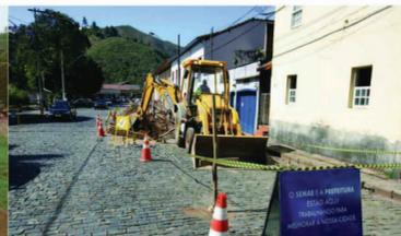
**INSTALAÇÃO DA NOVA REDE COLETORA DE ESGOTO NA BARRA**
