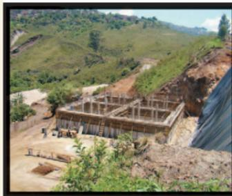
OBRAS DA ETA - GRANDE ESTAÇÃO DE TRATAMENTO DE ESGOTO
