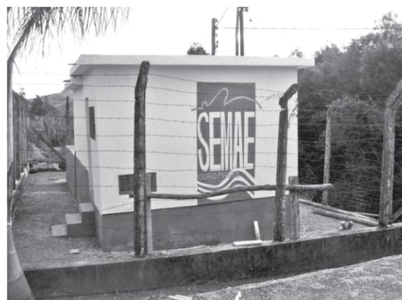
O distrito de Rodrigo Silva, município de Ouro Preto, possui duas fontes de abastecimento de água, uma captação superficial e um poço subterrâneo na qual a água é bombeada através de uma casa de bomba para abastecer a população.
