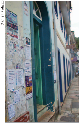
Local onde serão afixados cartazes na Rua São José
