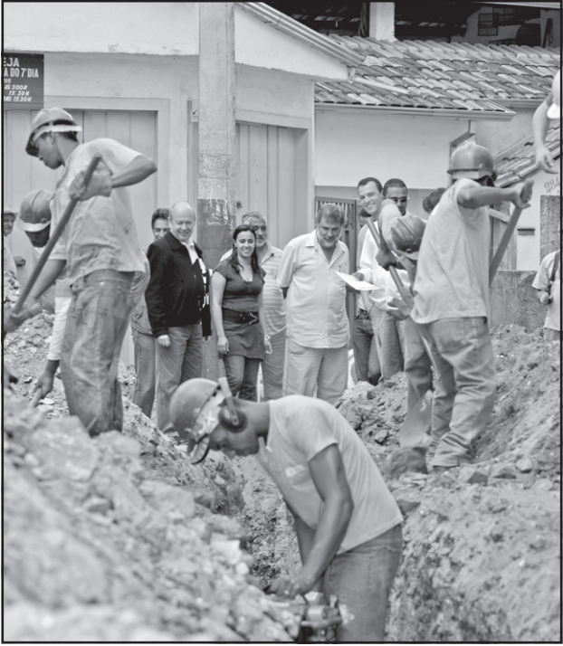
Obra do Semaef - Separação da rede de esgotos da pluvial
