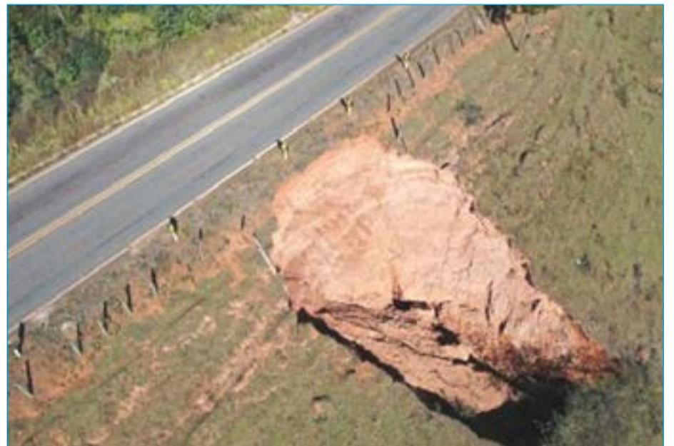
De acordo com o MPMG, por conta do processo erosivo, agravado pelas chuvas, o local se tornou uma área de risco para motoristas e passageiros que nele transitam. O trecho pertence à Estrada Real. “Tal rodovia é submetida a intenso trânsito diário de veículos pesados e a falta de contenção da erosão no local aponta para o iminente desabamento do trecho da rodovia, o que provocará acidentes com vítimas fatais”, afirmou o promotor de Justiça Pedro Henrique Pereira Correa.
