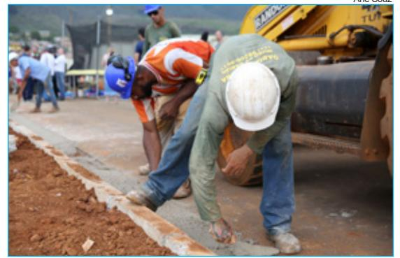
Instalação de meio-fio com canaletas de drenagem
