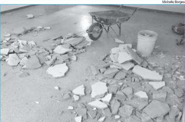
Na manhã da quinta-feira (8) emitiu um relatório informando o problema e assegurando que as aulas podem ser retomadas na segunda-feira (12). "Uma infiltração no teto ocasionou a queda de parte da estrutura. Observados que as madeiras de suporte da laje não foram retiradas e absorviam a umidade.
