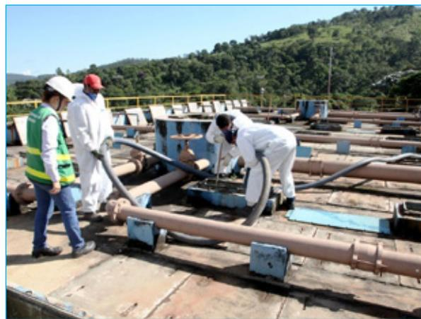
Para preservar as suas condições de operação e garantir a eficiência da unidade, o Serviço de Saneamento Básico (Saae) de Itabirito realizou na última quarta-feira (20/02) a limpeza dos tanques dos reatores UASB da Estação de Tratamento de Esgoto do Marzagão (ETE).
